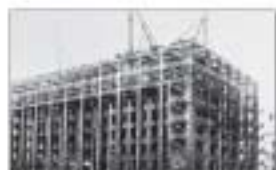
【1938 第一生命本社ビル鉄骨】
