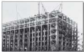
【1938 第一生命本社ビル鉄骨】
