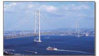
【1998 明石海峡大橋】
